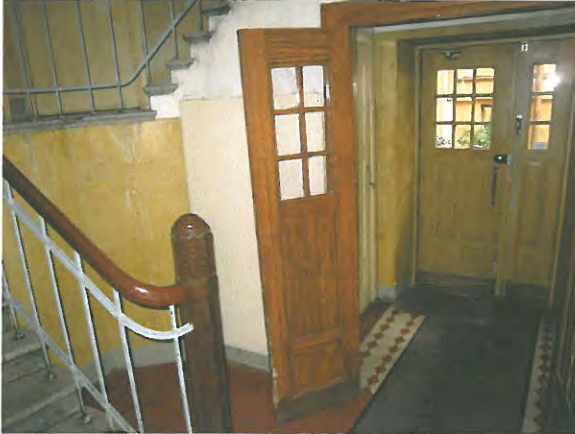
Kuva 1. B-portaan alatasanne ja porraskuilu.
