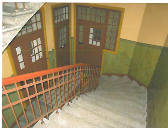
Kuva 8. C-portaan porraskuilua ja -askelmia.
